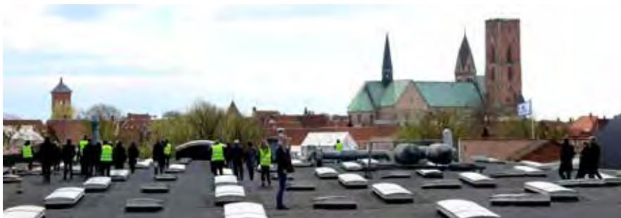
DELTAGENDE TEAMS, DOMMERKOMITE OG ØVRIGE INVOLVEREDE BESIGTIGER KONKURRENCEOMRÅDET OPPE FRA JERNSTØBERIETS STORE TAGFLADE.
